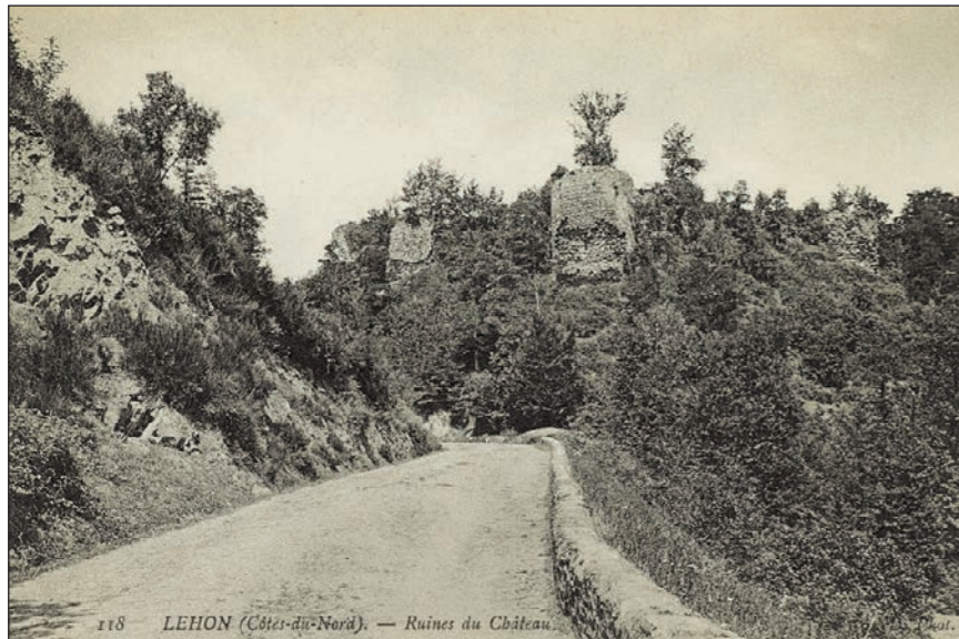
Fig. 122 : Léhon, ruines du château
